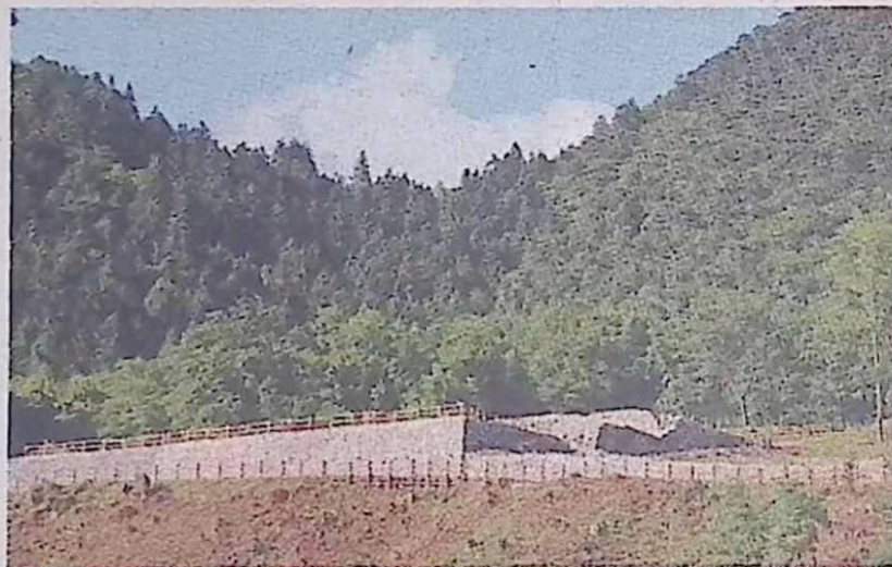
Ecco come appare la zona di Prà Castello dopo i lavori di recupero
