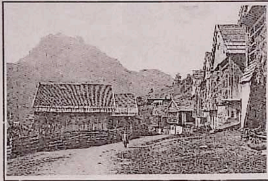
L'elemento caratterizzante delle costruzioni tradizionali è l'uso di legno, quando non calcinacci, del legno: gli esemplari più famosi, sia nelle parti portanti che negli elementi di finitura, i tralicci, sono costruiti in legno di larice, sono sovrapposti e incastrati alle estremità con creste delle pareti contigue, secondo la sacrale tecnica di unione portanza. In alto: tipicità di un abitacolo della località di S. Pietro di S. Pietro, costruita a secolo dell'incendio che nel 1908, la disastrosa quasi completamente. Caricatura postale del 1925 (collezione privata). In basso: l'insediamento di S. Pietro di S. Pietro, in alto: un disegno di fine 1800 nella quale è possibile notare la disposizione dei tralicci e l'uso dei materiali della tradizione. Caricatura postale del 1925 (collezione privata). Entrambe le immagini sono tratte dal periodico Le Dolomiti belline , Sappada-Palazzo, n. 274.
