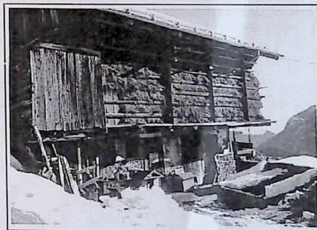
In questa pagina altre due immagini di costruzione in legno: a lato della cascata a Sauris di Sotto, in alto, l'ascorta del fieno in località Mena; in basso, un paesello alpino. In entrambi si può notare la struttura in legno dei piani superiori, con l'appoggio di robuste travi che durante i mesi invernali, mantengono il fienile necessario. Foto G. Giombato, fornite dal Comune di Sauris (UD).
