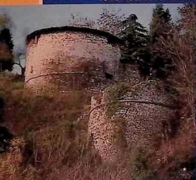
TORRE MOZZA E TORRE BASSA
