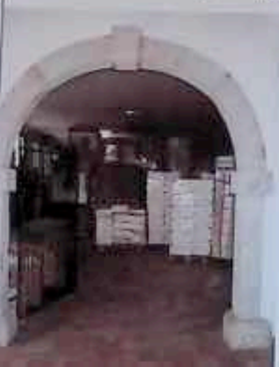
Una dei locali della cantina
