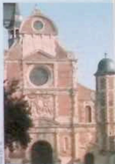
St. Chapelle de l'ancien collège des Jésuites
