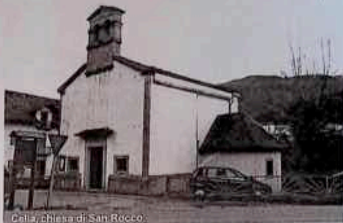
Cella, chiesa di San Rocco.
